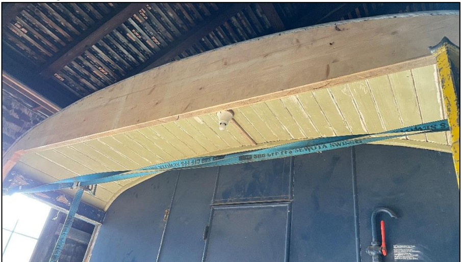
Neuer Dachabschluss am Guisanwagen
